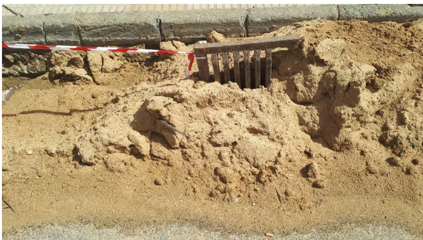
OBRAS MUNICIPALES "PERFECTAMENTE" SEÑALIZADAS Y BALIZADAS
