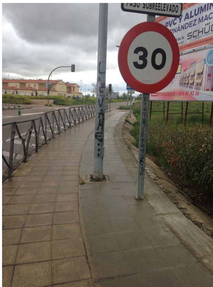
MOBILIARIO Y SEÑALIZACIONES COLOCADOS PARA "FACILITAR" EL PASO A LOS PEATONES
